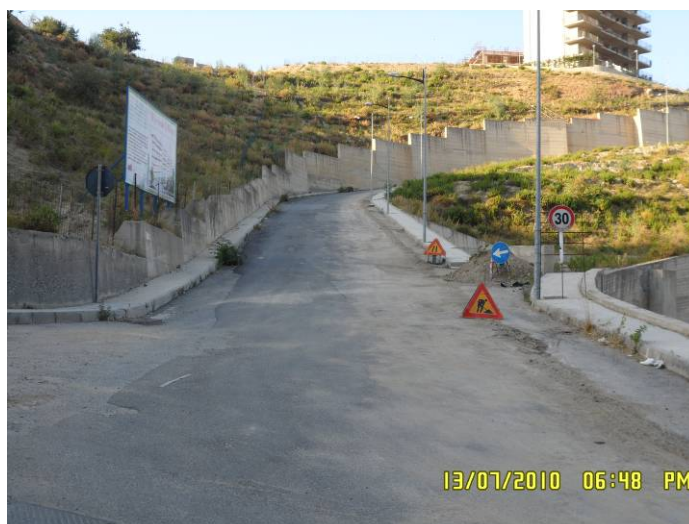
Foto 4.10 - Stato delle caditoie stradali e delle griglie nella via Torrente Trapani
