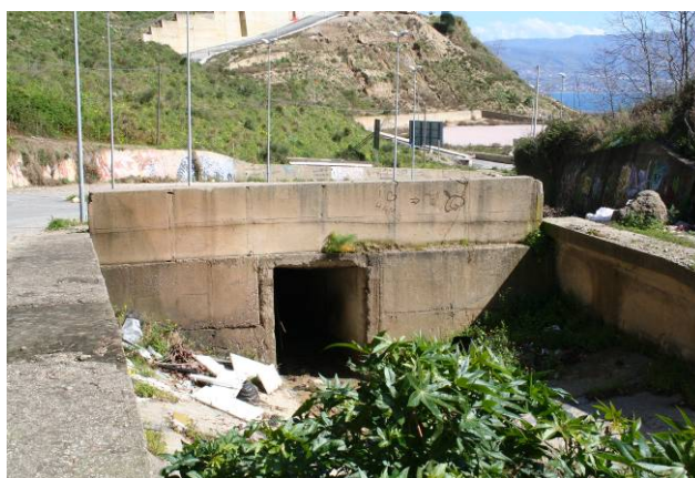
Foto 4.1 – Vista da monte dell'imbocco del tratto tombato
