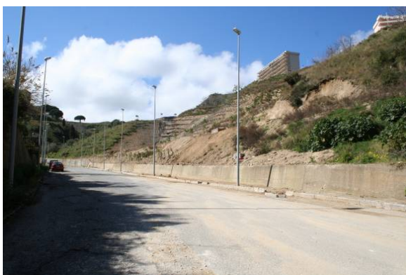
Foto 4.2 – Particolare dei versanti in erosione
