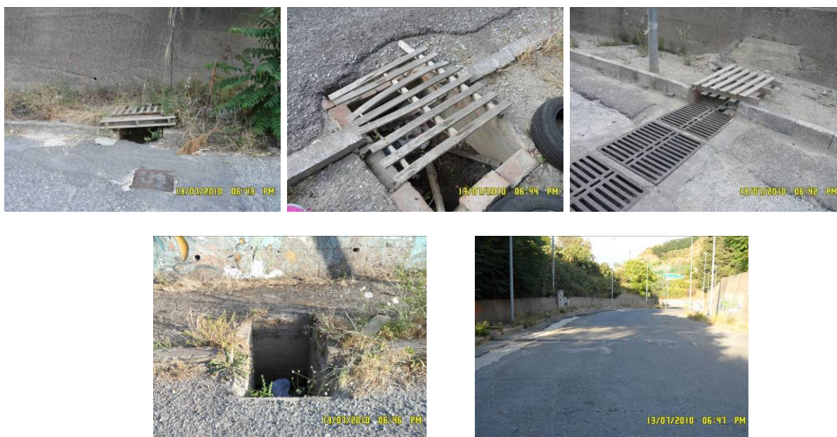
Foto 4.9 - Stato delle caditoie stradali e delle griglie nella via Torrente Trapani
