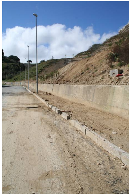
Foto 4.3 – Particolare punto immissione sedimenti su sede stradale
