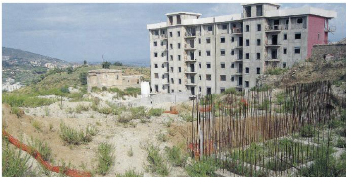
Basta con gli errori del passato. Uno dei cantieri edili "stoppati" sul torrente Trapani
